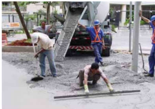
Figura 10 – Recebimento e espalhamento do concreto.
