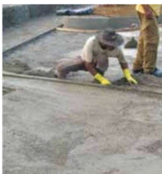
Figura 11 – Sarrafeamento do concreto.
