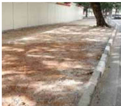
Figura 8 – Nivelamento e compactação do terreno
